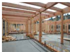
構造体の柱や梁には歪みにくく強度の高い集成材を使用。
