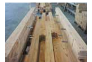
協定工場で構造用集成材に高耐久金物を取り付け加工。
