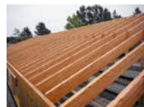
傾斜屋根を支える集成材の梁。
